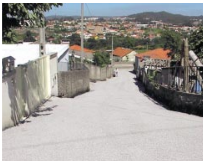
Pavimentação da Travessa do Cruzeiro
