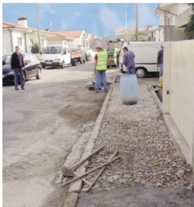
Construção de Passeios na Rua de Romão
