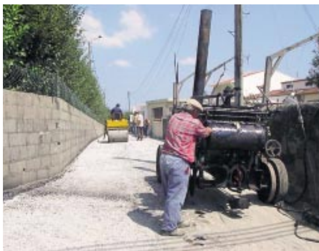
Pavimentação da Travessa Camilo Castelo
